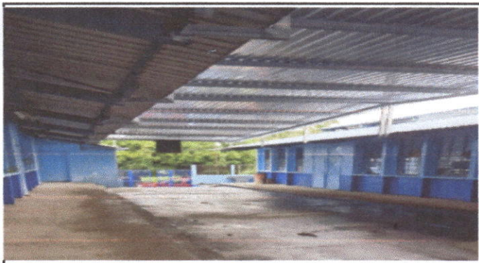
Foto 3: TECHADO DE CANCHA DE LA ESCUELA
