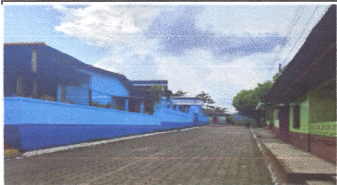
Foto 1: PINTURA DE MUROS EXTERIORES E INTERIORES DE LA ESCUELA.
