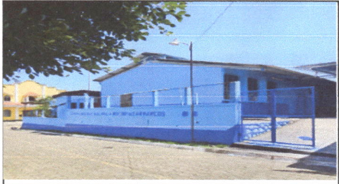
Foto 2: PINTURA DE MUROS EXTERIORES E INTERIORES DE LA ESCUELA.
