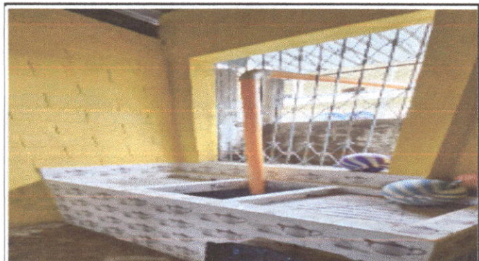
Foto 4: INSTALACIONES NUEVAS DE LA COCINA
